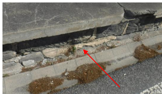
Obr. 25 a 26 – Spáry mezi odvodňovačem a vozovkou – nečistoty, náletové rostliny
