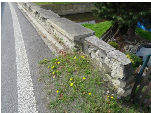
Obr. 20 a 21 – Krycí desky poprsních zídek – spáry u vozovky
