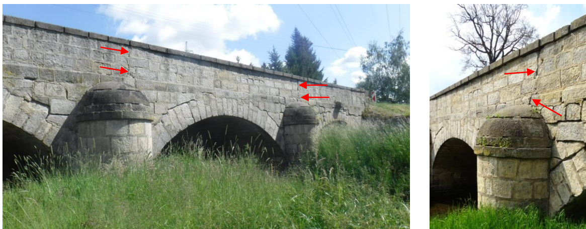
Obr. 10 a 11 – Trhliny nad pilíři – oddělení střední klenby
