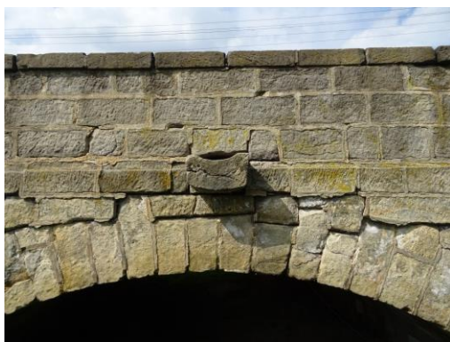
Obr. 1 a 2 – Trhlina mezi klenbou a poprsní zídou
