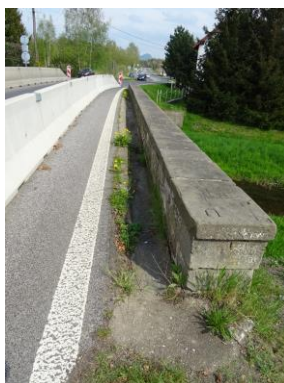
Obr. 22 - 24 – Pohled na zábradlí (poprsní zídky mostu) – spáry u vozovky
