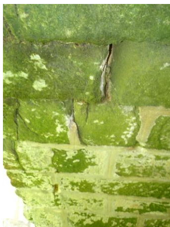
Obr. 8 a 9 – Uchycení řas na konstrukci
