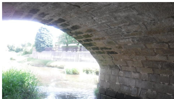
Obr. 7 – Podélná trhлина v klenbě
