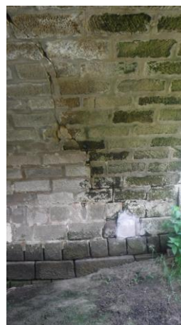
Obr. 8 a 9 – Uchycení řas na konstrukci
