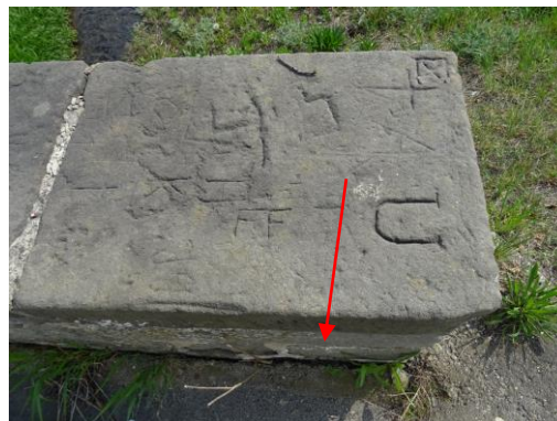
Obr. 20 a 21 – Krycí desky poprsních zídek – spáry u vozovky
