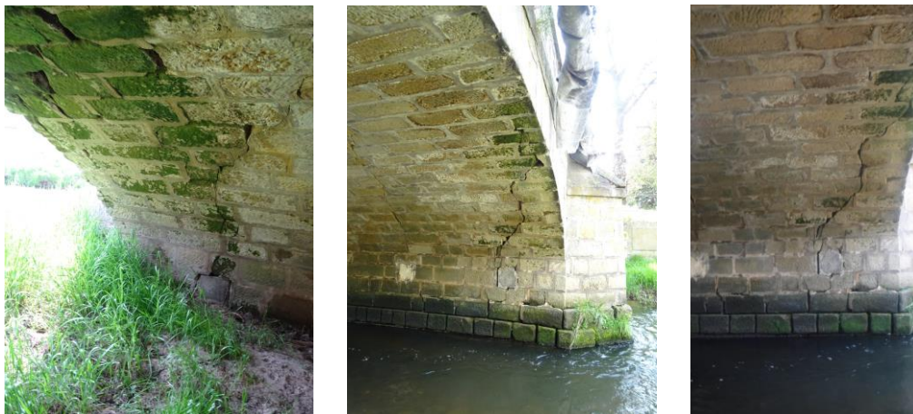
Obr. 3, 4, 5 – Podélná trhлина v klenbě
