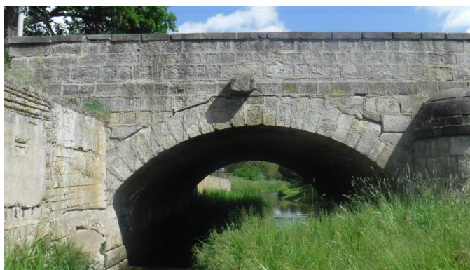
Obr. 1 a 2 – Trhlina mezi klenbou a poprsní zídou
