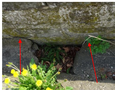
Obr. 22 - 24 – Pohled na zábradlí (poprsní zídky mostu) – spáry u vozovky
