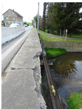
Obr. 22 - 24 – Pohled na zábradlí (poprsní zídky mostu) – spáry u vozovky
