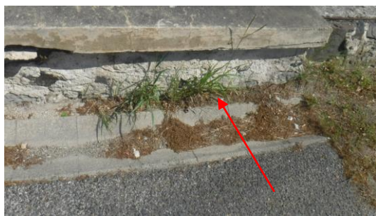
Obr. 25 a 26 – Spáry mezi odvodňovačem a vozovkou – nečistoty, náletové rostliny
