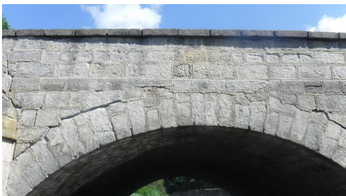
Obr. 6 – Trhлина mezi klenbou a poprsní zídrou
